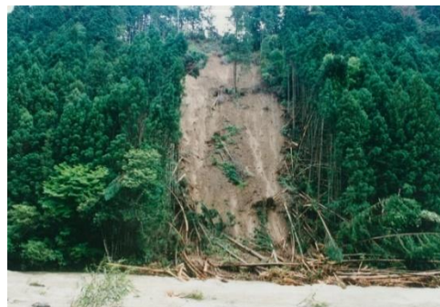
丹生川沿いの崩落箇所
