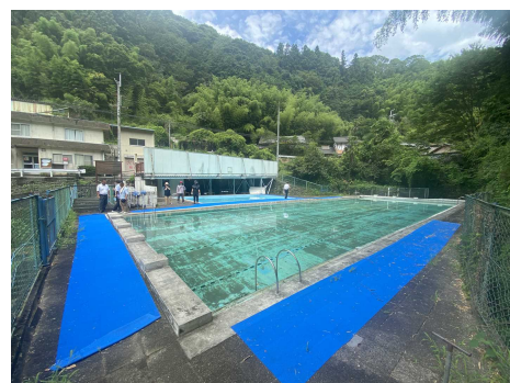
河根小・中学校プール
