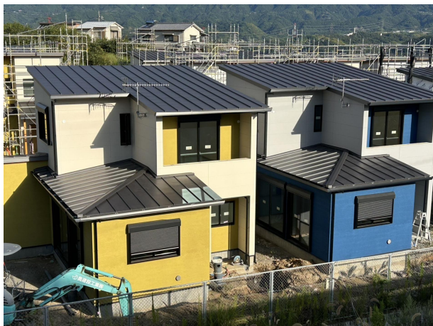
▶ 建設中の様子
