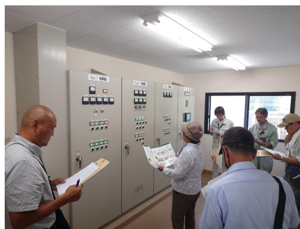
▲現地調査の様子
