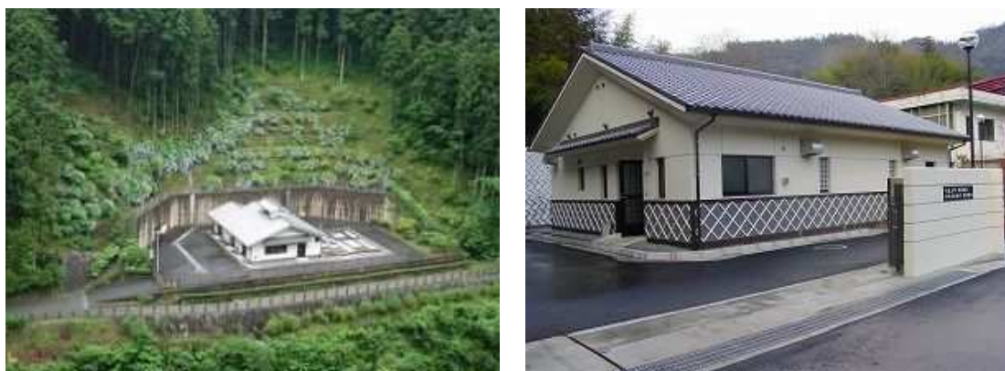
図 2-2 椎出地区処理場（左）、河根地区処理場（右）
