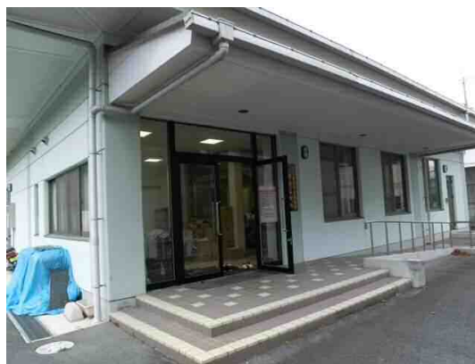
＜九度山町簡易水道施設中央監視所＞
