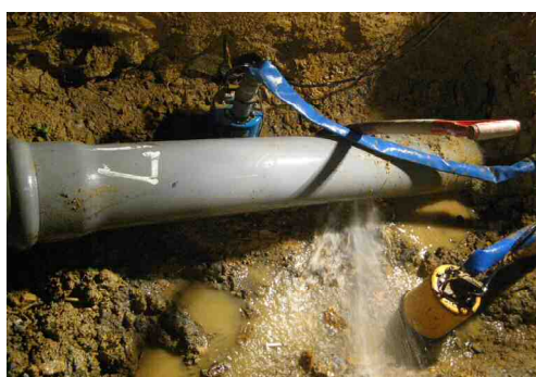
＜配水管事故の復旧作業＞
