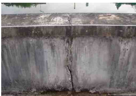
＜九度山浄水場の緩速ろ過池＞
