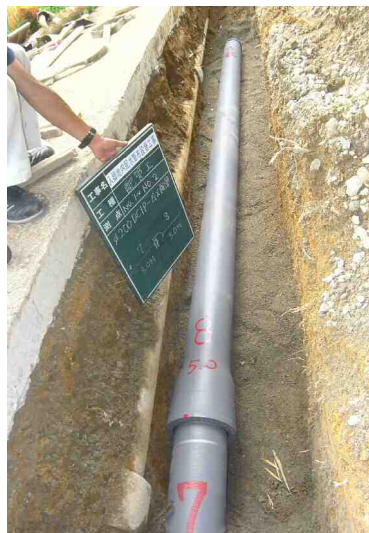
＜管路の耐震化工事＞
