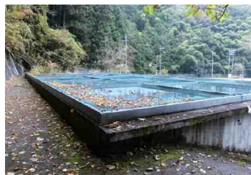
＜緩速ろ過池の落葉防止用ネット＞
