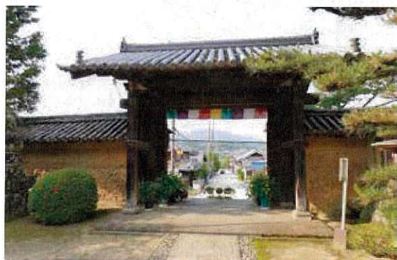
写真 2-6 北門と築地塀 遠景は紀の川
