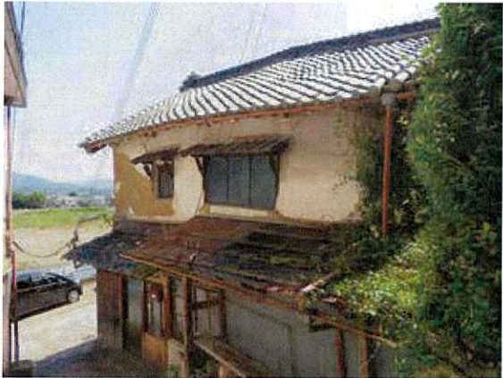
写真 3-25 木造庇屋根の持送（矢羽根）
