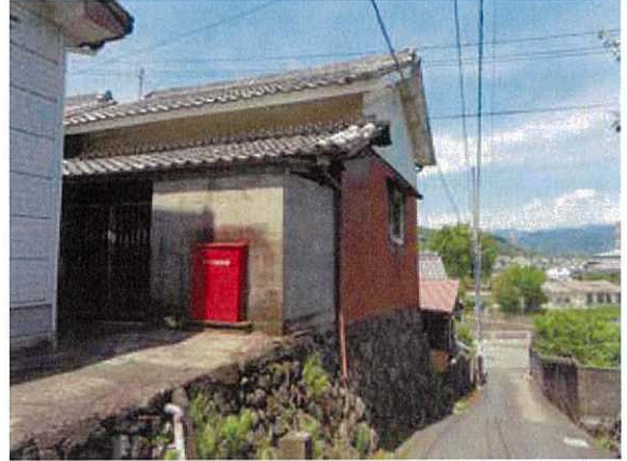
写真 3-30 傾斜地に建つ土蔵（南通西端）
