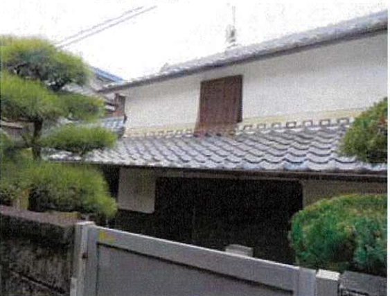
写真 3-27 前面庇と接続建物
