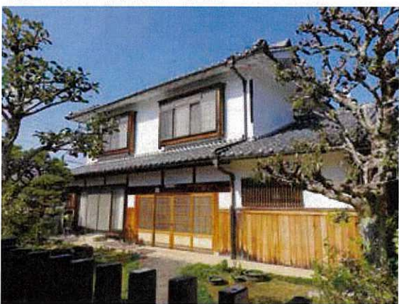
写真 3-136 中通 青木家 修復
