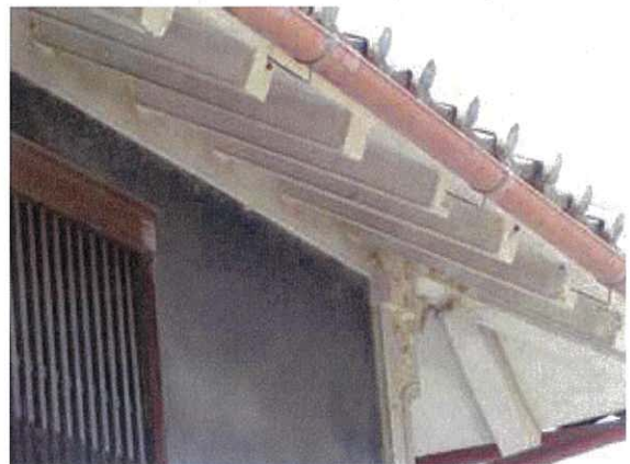
写真 3-63 ツシ 格子窓塗装
