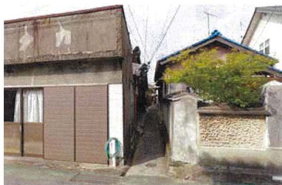
写真 3-132 土塀洗出 中通・中部
