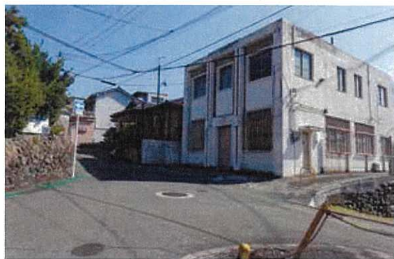
写真 3-130 近代建築 中通・西端
