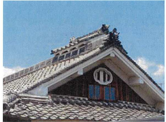
写真 3-61 虫籠窓 妻に設置（煙出し）
