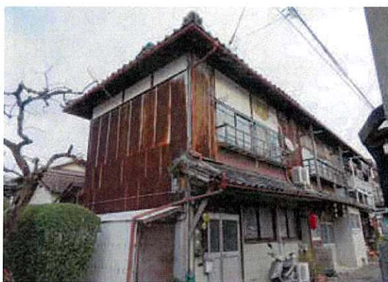
写真 3-287 西方 集合住宅
