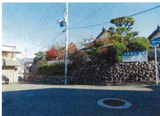
写真 3-146 西端の状況 1 (撤去)
