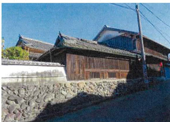
写真 3-148 元医院 (旧宿屋) (撤去)
