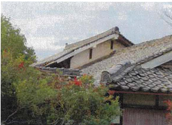
写真 3-281 南端部 本瓦葺の主屋
