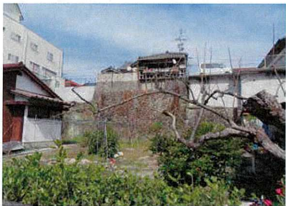
写真 3-200 南側傾面の状況
