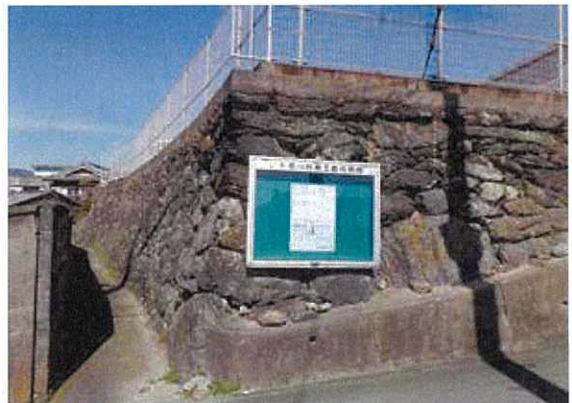
写真 3-194 旧観音寺跡 石垣
