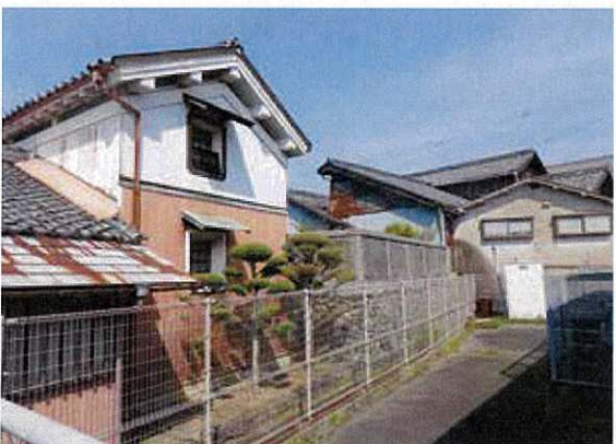
写真 3-202 土蔵と織物工場
