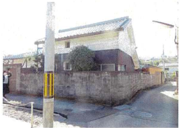
写真 3-268 永代橋 北西方
