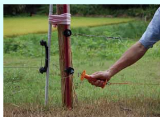
侵入防止柵の設置
